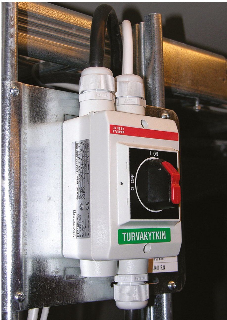
Joonis 21.4. Masina ootamatu käivitumise vältimiseks võib kasutada näiteks turvalülitusseadmeid.
