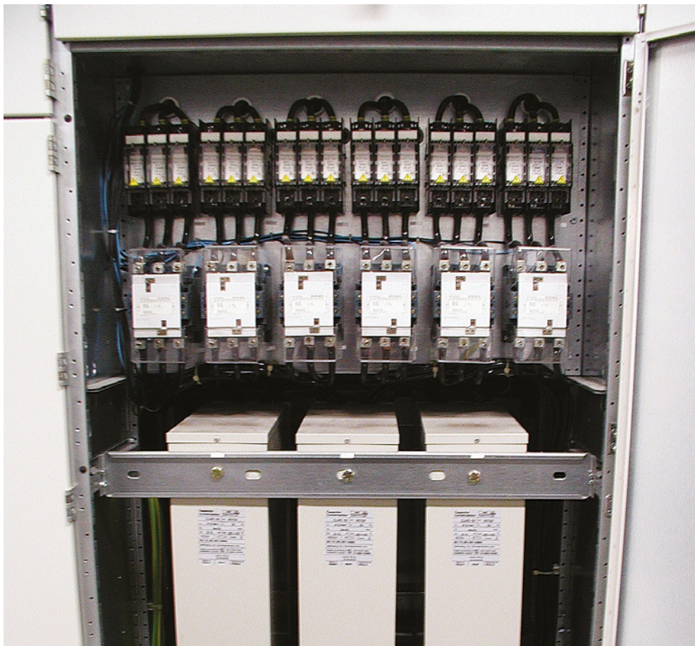
Joonis 21.7. Ohtliku jääkpinge kõrvaldamine peab olema tagatud
