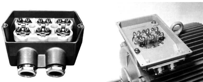
Joonis 17.7. Vasakul on näidatud (HXA 160 ja 180 tüüpi mootori) steatiidist klemmkarbi põhi koos ühendusklemmide ja läbiviigu tihenduspuksidega. Paremal on valatud klemmkarp, millel on valuvaigust põhi ja kaks alternatiivset ühendusviisi.
