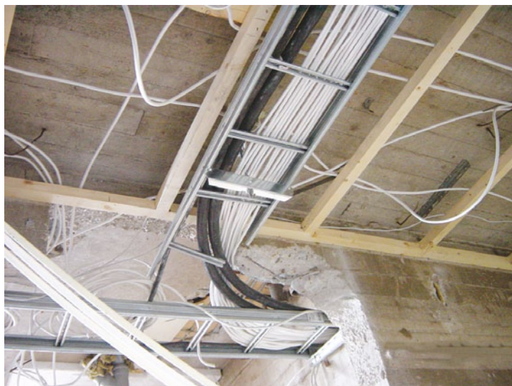
Joonis 7.1 Alumiiniumist kaabliredelite (-rennide) eeliseks on muuhulgas vähene kaal
