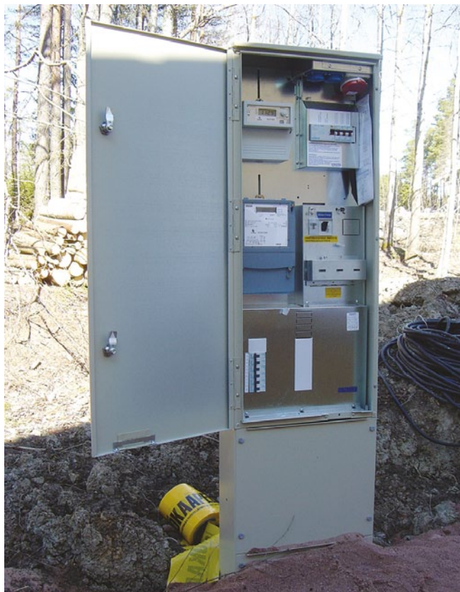
Joonis 2.14 Jaotusvõrguettevõtte on märkinud lühisvoolu suuruse liitumispunktis
