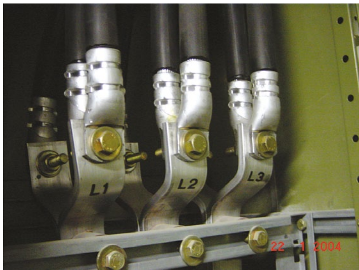
Joonis 8.2 Press- ja poltliited
