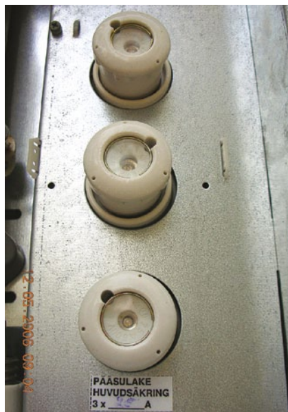
Joonis 5.3 Üldjuhul kasutatakse sulavkaitsmeid endiselt peakaitsmetena
