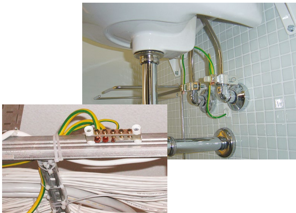
Joonis 4.11 Erinevail põhjustel tehtud potentsiaaliühtlustusi
