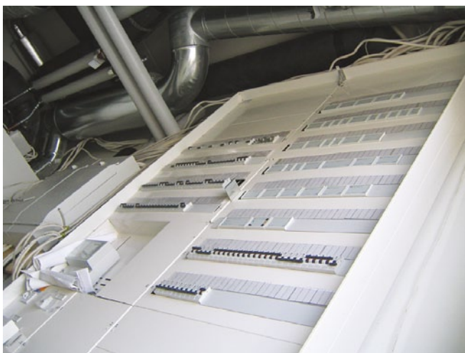
Joonis 2.19 Peakilp tehnilises ruumis
