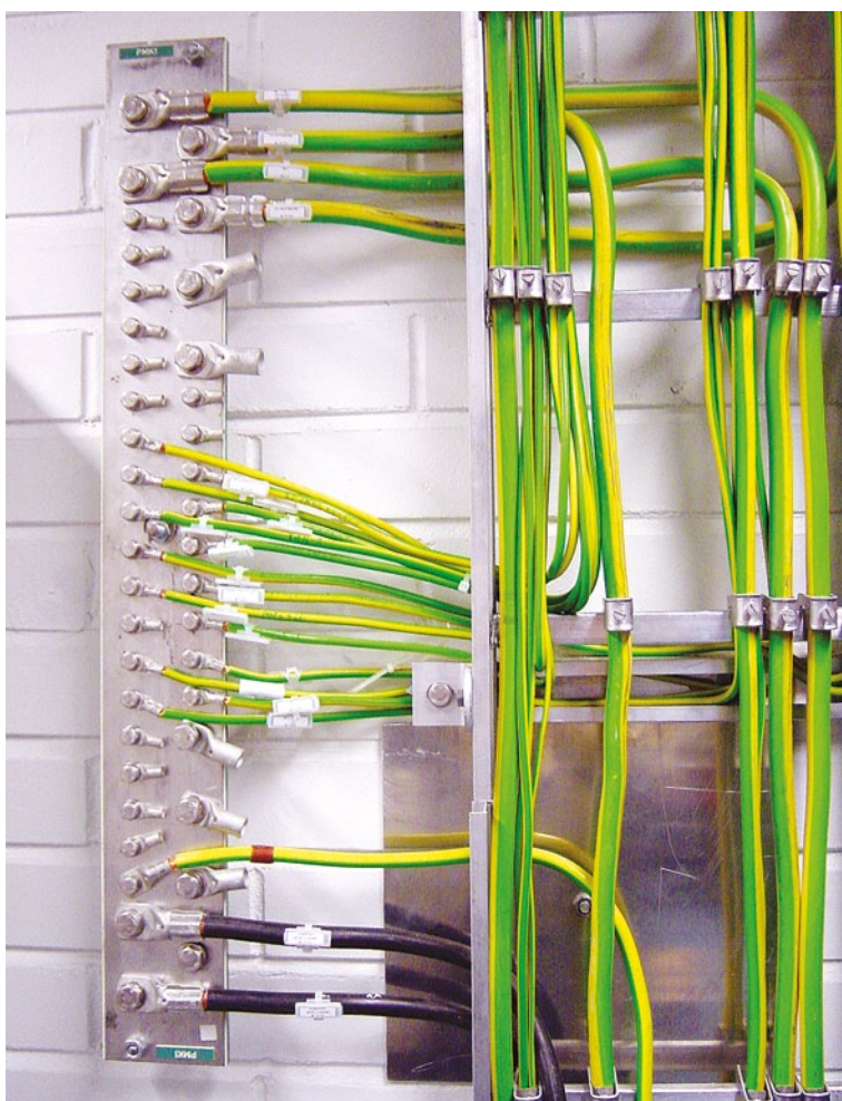
Joonis 4.7 Potentsiaaliühtlustuses ühendatakse kõrvalised juhtivad osad pingealtide juhtivate osadega
