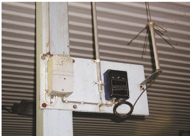
Joonis 6.5. Maamajandusehitistes tuleb kaablite mehaaniline kaitse kinnitada eriti hoolikalt
