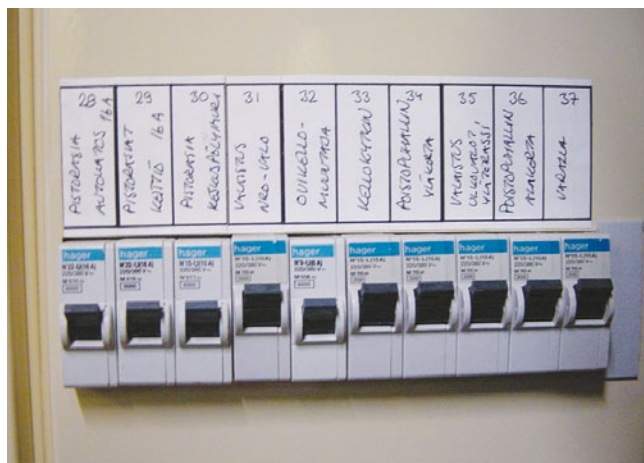
Joonis 5.1 Liinikaitselülitid on lõppvooluahelate kaitsest sulavkaitsmed välja tõrjunud
