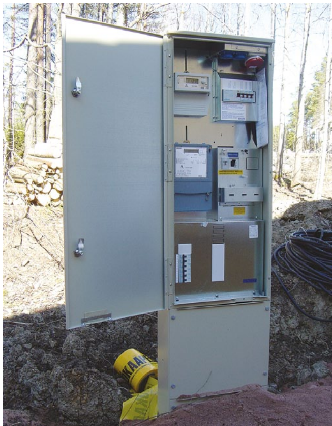
Joonis 2.17 Peakilbi ülesannet täidab krundi liitumiskilp
