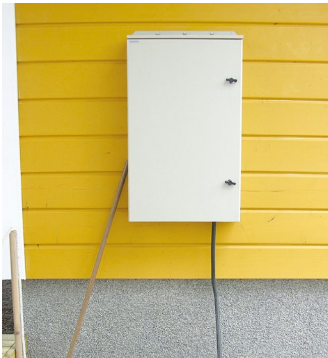
Joonis 2.18 Peakilp hoone välisseinal
