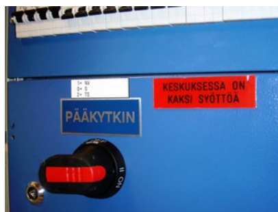
Joonis 12.3. Kilbi väljalülitamine toimub enamasti kilbis paikneva pealüliti kaudu.
