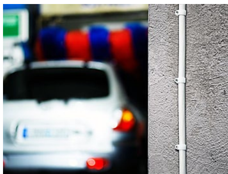
Joonis 9.7. Pinnapealne paigaldus kergkruusast aluspinnale (Schneider).
