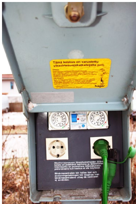
Joonis 10.9 a ja b. Ühendusjuhe on jäetud nõuetekohaselt kohale.
