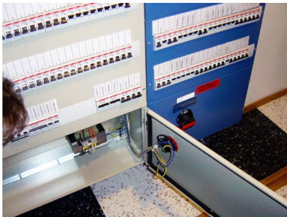
Joonis 12.5. Kilbis ees peab olema piisavalt ruumi käidu- ja hooldustoiminguteks ka avatud ukse korral.
