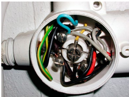
Joonis 14.2. Tarvitiiliini jätkamisel peab klemmide jaoks olema piisavalt ruumi ja klemmid peavad olema kasutatud juhtme ristlõike pindala ja ehituse jaoks sobivad.
