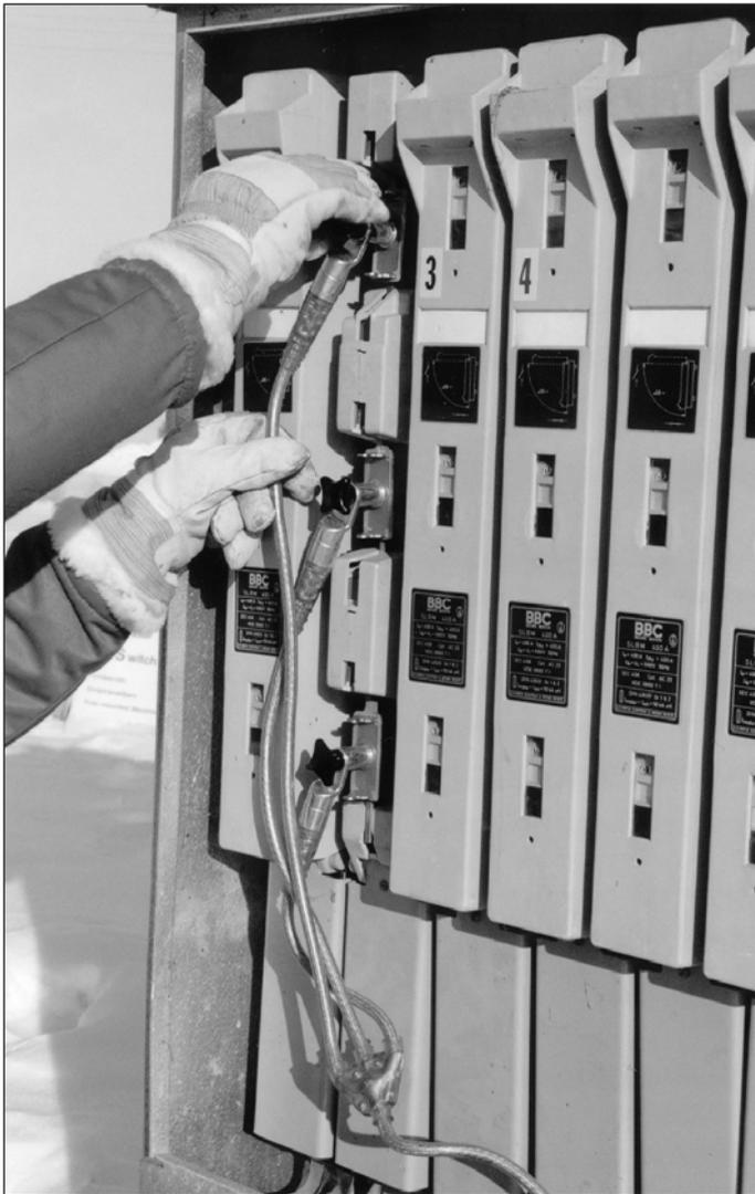
Рисунок 284. Вместо удаленных рычажных предохранителей устанавливаются т.н. полупредохранители, заземляющие провода выхода на время работы.
