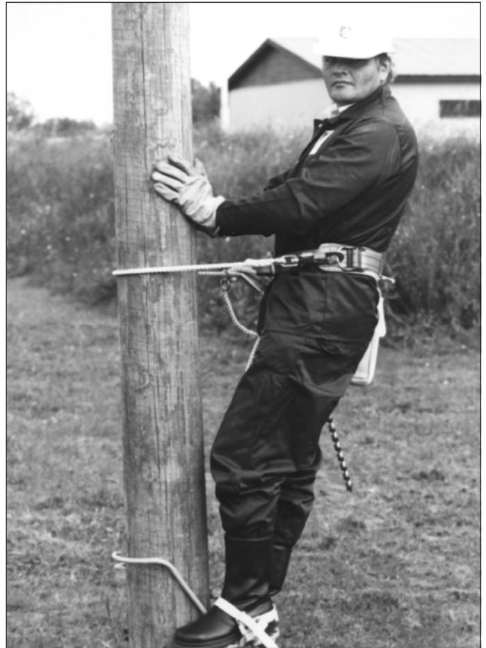
Рисунок 149. После выполнения пары шагов проверить прочность крепления пояса, для чего нужно резко опереться на пояс.
