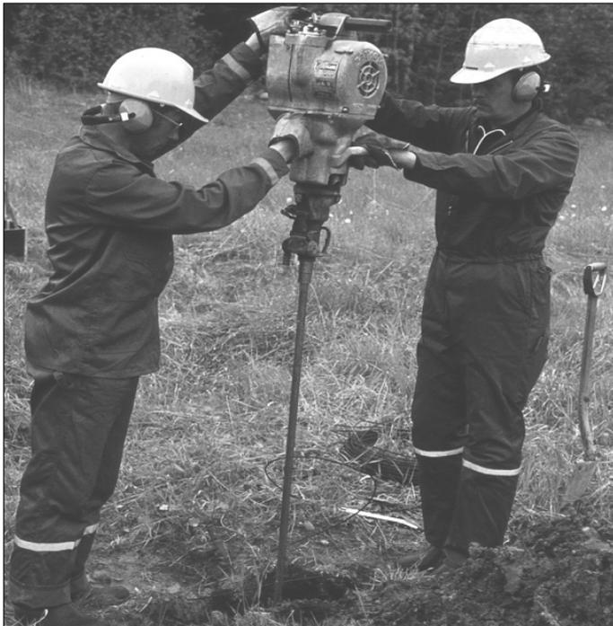
Рисунок 45. Установка сопровождающего стержня с помощью буровой машины.
