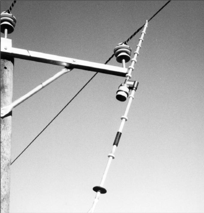
Рисунок 379. Индикатор напряжения для наружного применения.
