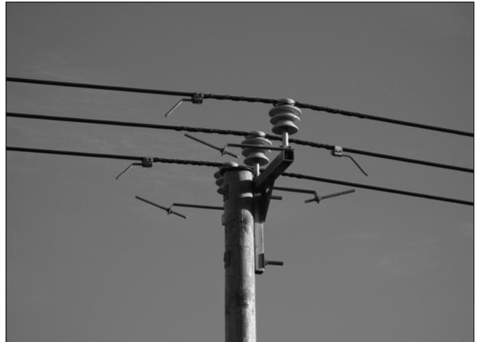
Рисунок 405. Искровой разрядник, установленный на горизонтальную траверсу (Ensto).
