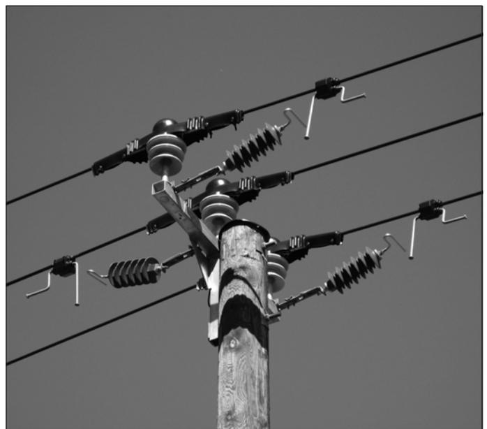
Рисунок 406. Угловая траверса, искровой разрядник, кронштейн для монтажного ролика провода PAS, искровой зазор на натяжном изоляторе (Ensto).
