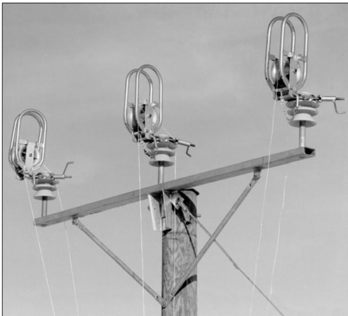
Рисунок 333. Тяговые веревки, установленные на монтажные ролики.
