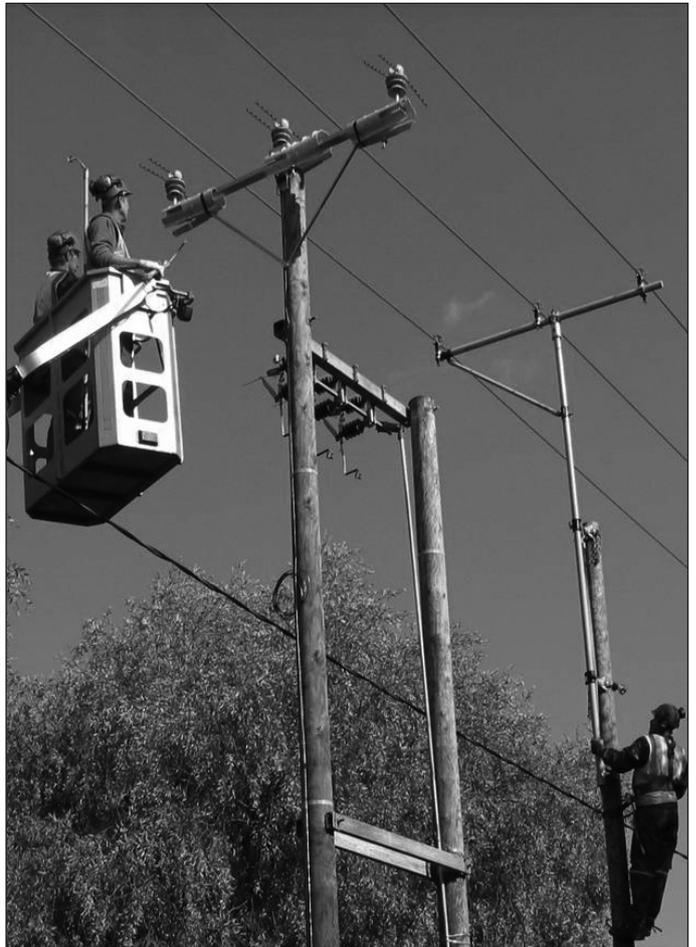
Рисунок 469. Замена опоры с помощью подъемной траверсы (JT-MILLENNIUM).
