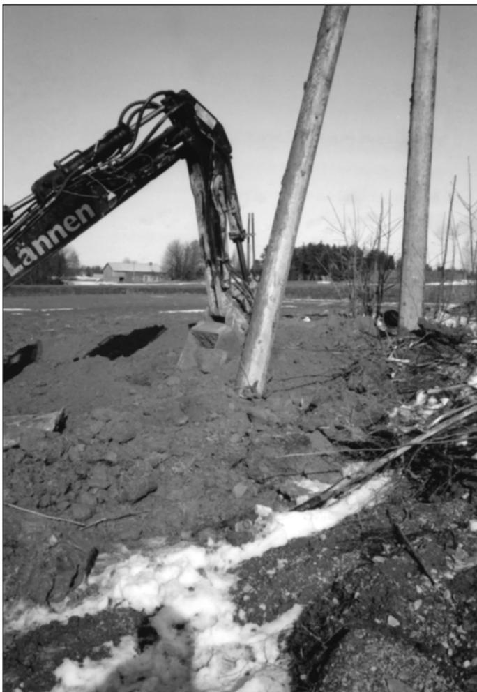
*Рисунок 165. Обработка грунта вокруг опоры.*
