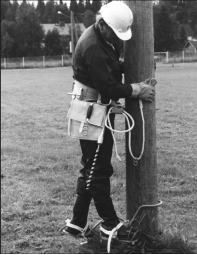
*Рисунок 155. Строп отсоединяется только на земле.*
