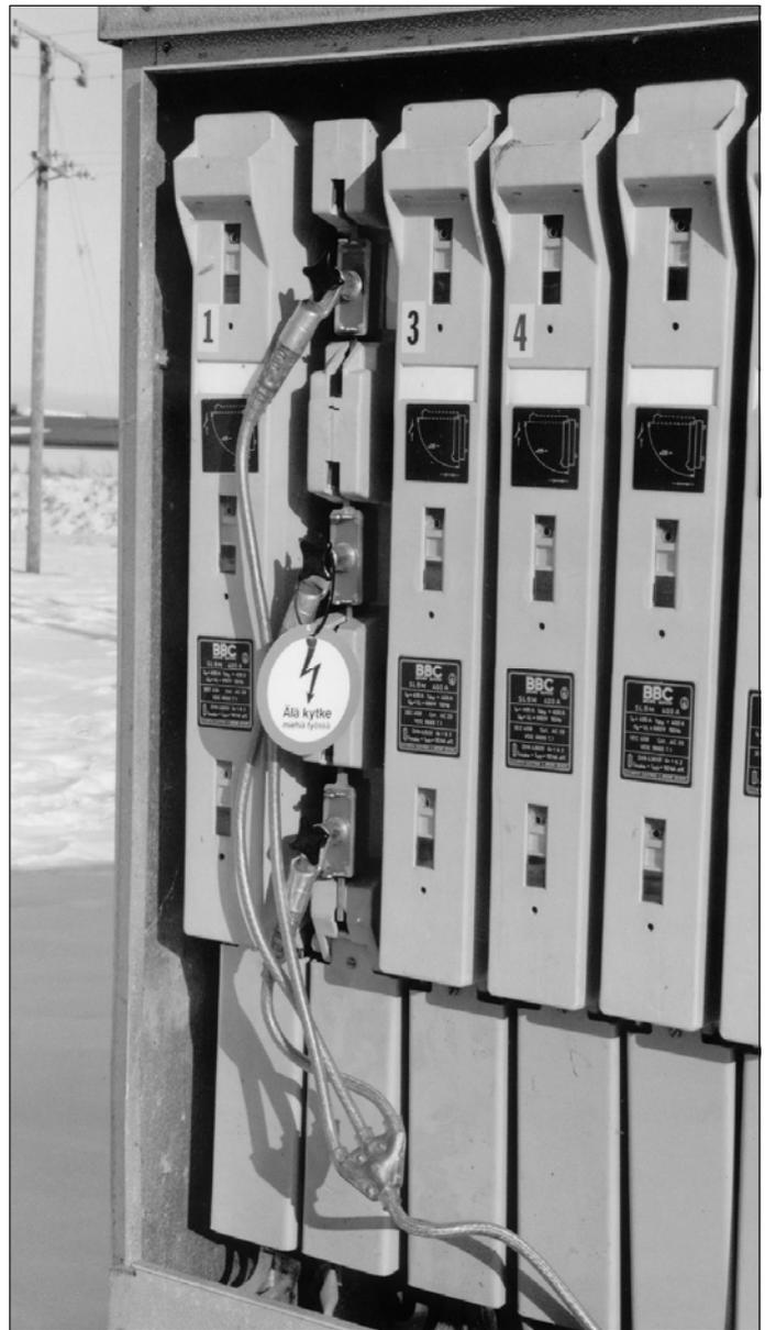
Рисунок 285. Кабельный щит и рабочее заземление, установленное в кабельный распределительный шкаф.
