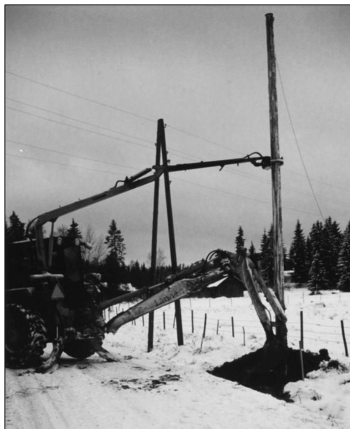
*Рисунок 164. Весь вынутый грунт засыпается в котлован и уплотняется.*
