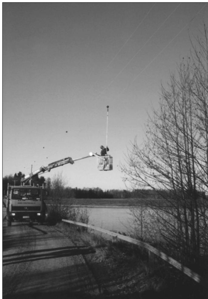
Рисунок 60. На воздушную линию электропередачи, пересекающую водоем, устанавливаются шары для предотвращения столкновения птиц с проводами, работа выполняется под напряжением.
