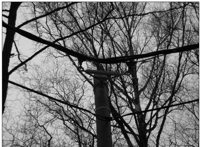
Рисунок 423. Пример углового монтажа универсального кабеля (Enpower)..
