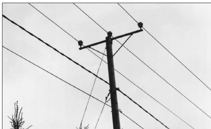
Рисунок 298. Линия электропередачи напряжением 20 кВ с неизолированными проводами на общей опоре.
