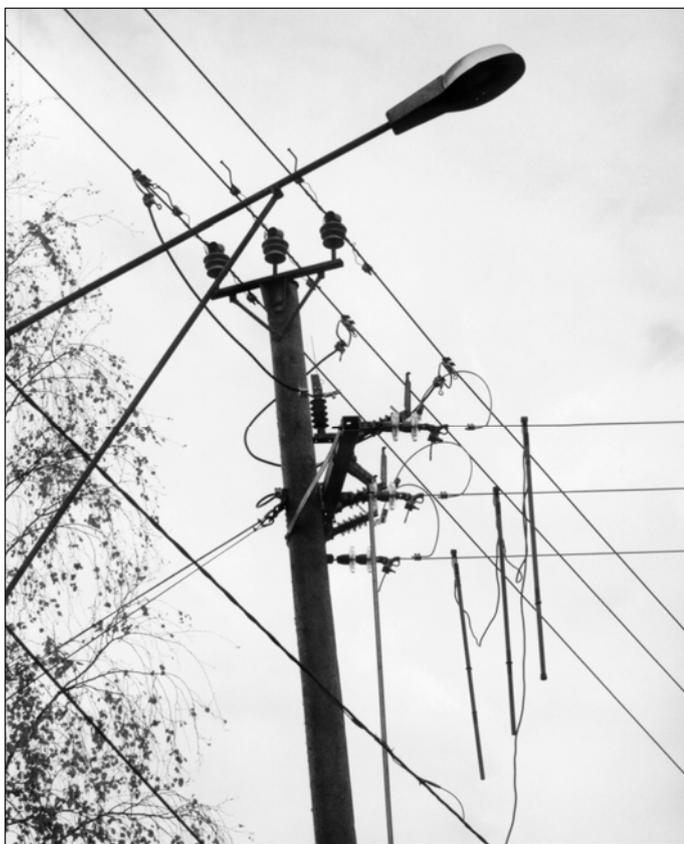
*Рисунок 416. Соединение неизолированного ответвительного провода с проводом PAS, работа под напряжением.*
