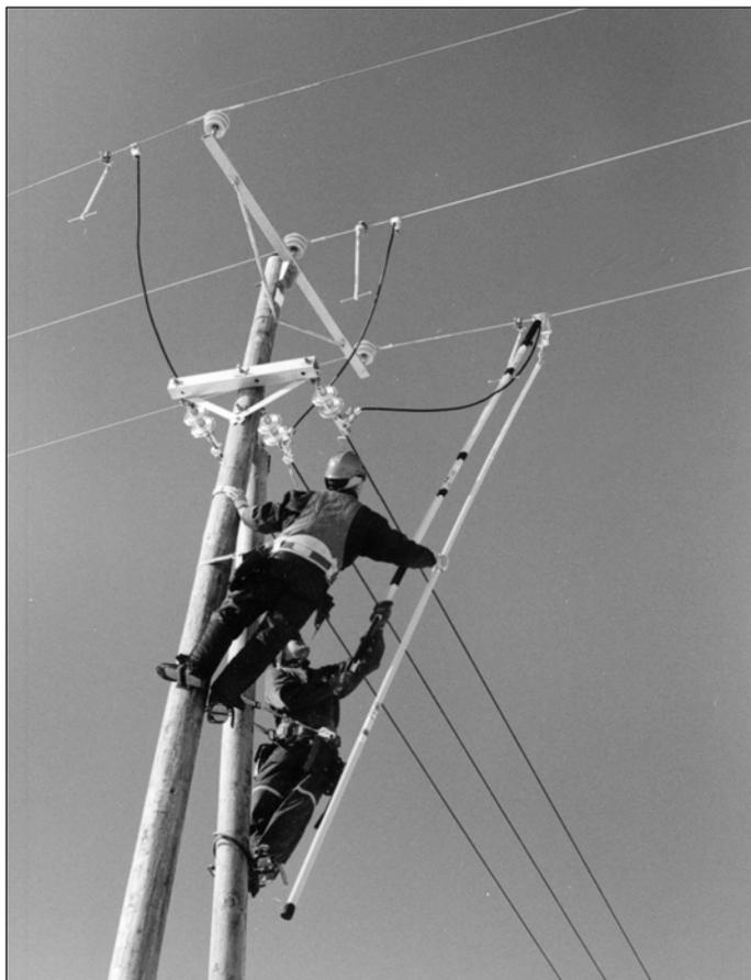
*Рисунок 415. Соединение ответвительного провода PAS с неизолированным проводом, работа под напряжением.*
