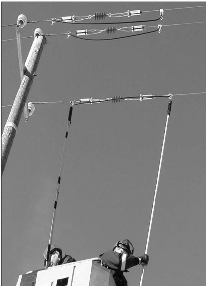
Рисунок 450. Установка разъединителей на воздушной линии электропередачи, работа под напряжением (JT-MILLENNIUM).
