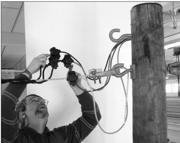
*Рисунок 271. Соединение провода АМКА с питающим кабелем с помощью болтовых зажимов.*
