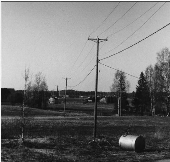
Рисунок 207. Провод АМКА на опоре с защищенными изоляцией проводом 20 кВ.
