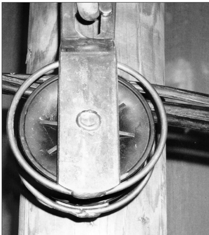
Рисунок 499. Установленные кронштейны и монтажные ролики провода АМКА.
