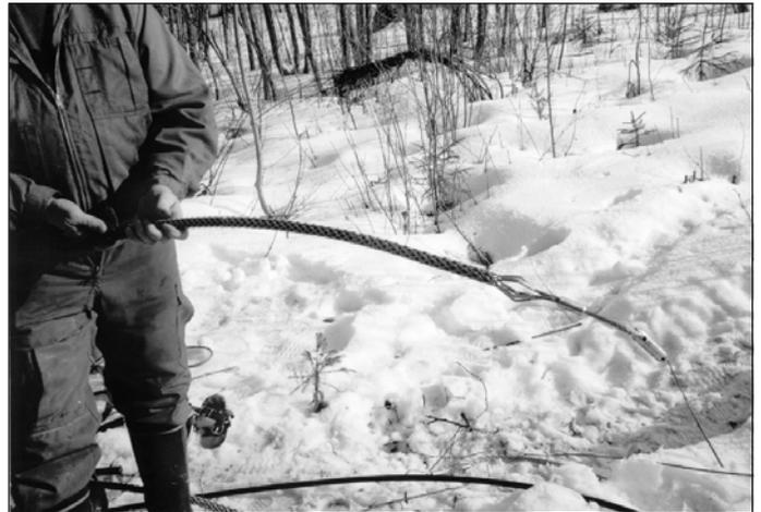
Рисунок 394. Соединение провода PAS с монтажным чулком.
