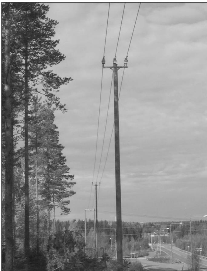
Рисунок 59. Линия с проводами PAS на обочине дороги.
