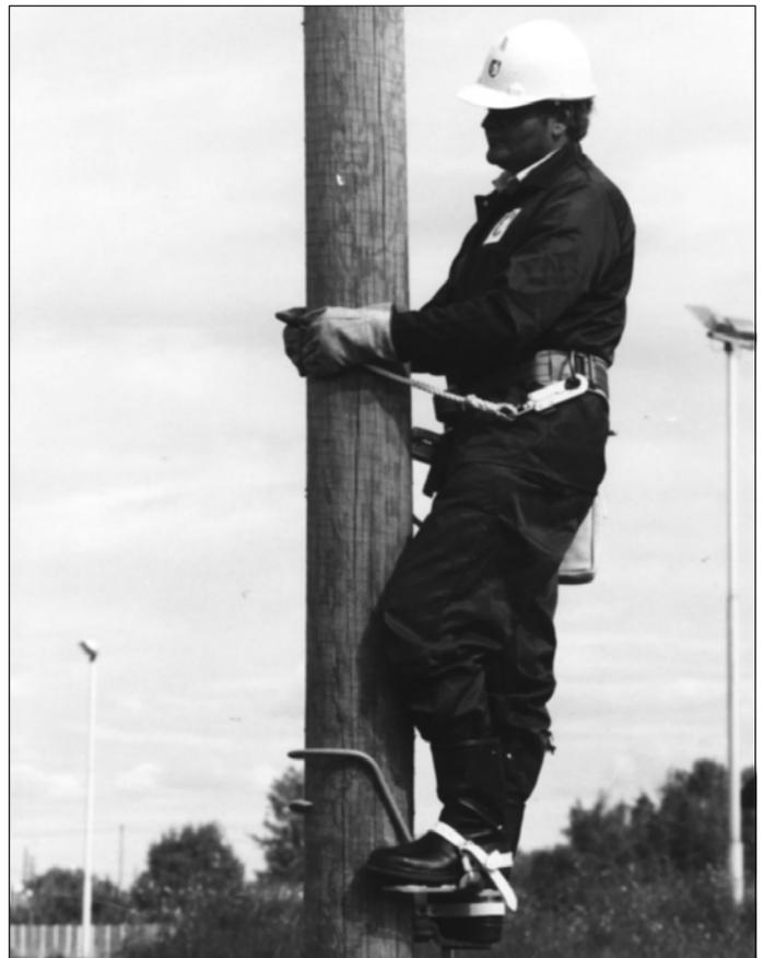
Рисунок 150. Подъем продолжать короткими шагами с выпрямленной спиной, удерживая колени максимально близко к опоре.
