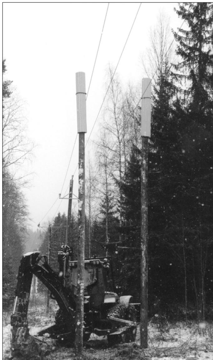
Рисунок 467. Установка опоры с применением изолирующего коврика при работе под напряжением.
