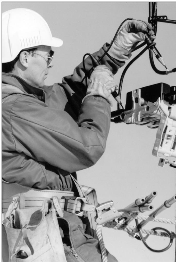
Рисунок 287. Обесточенность проверяется с помощью 2-полюсного индикатора напряжения.
