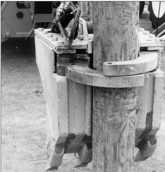
Рисунок 524. Укрепление опоры экскаватором.
