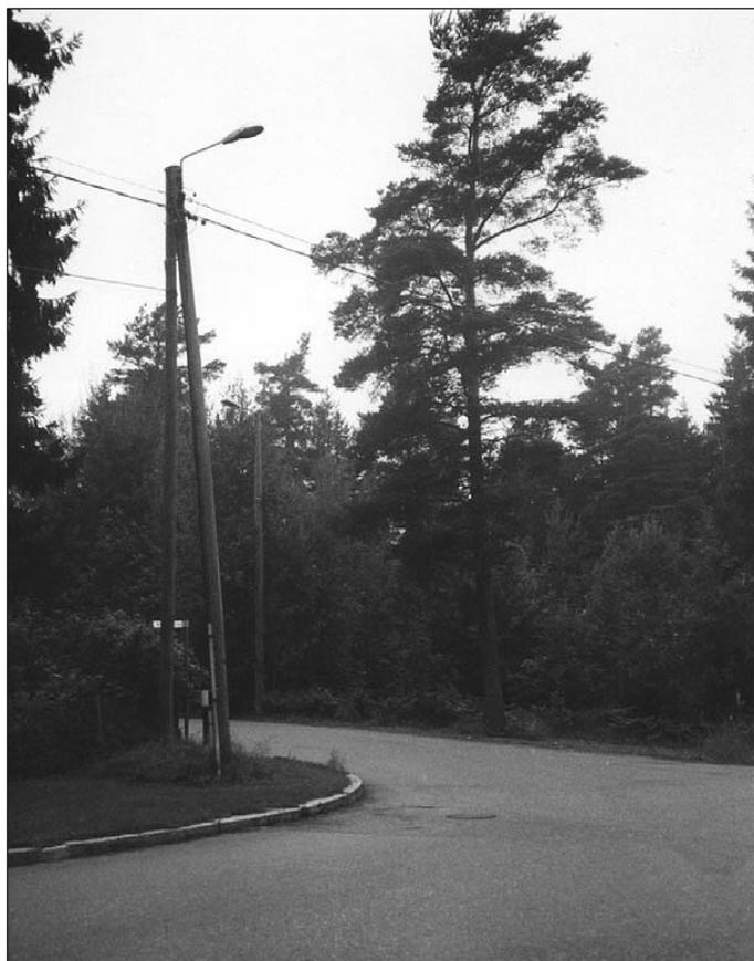
Рисунок 208. Провод АМКА для дорожного и уличного освещения на общей опоре с телекоммуникационным проводом.
