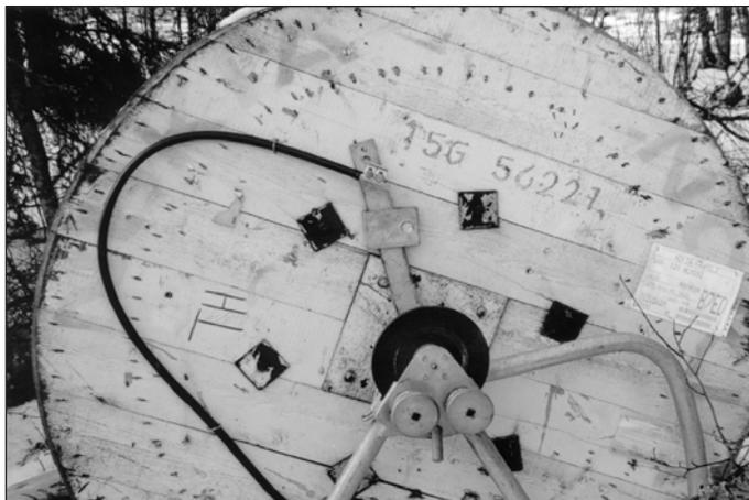
Рисунок 409. Рабочее заземление провода PAS на барабане во время раскатки.
