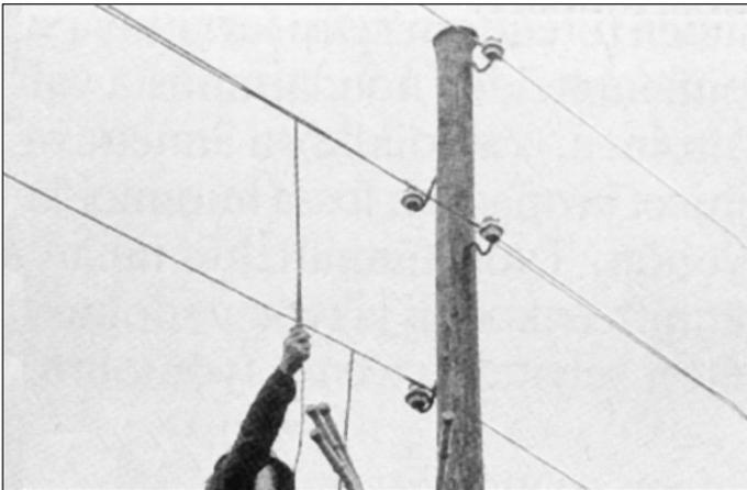
Рисунок 503. Проверка отсутствия напряжения на линии низкого напряжения.
