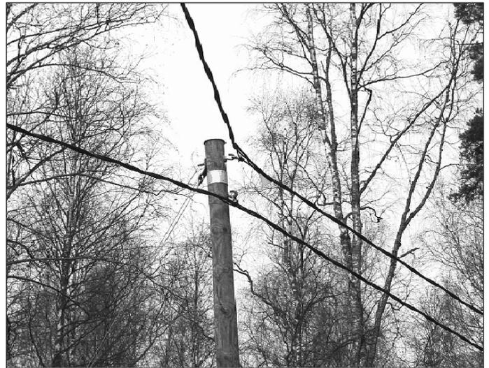
Рисунок 275. Предупредительная лента на опоре провода АМКА 1 кВ (YJ7:06, рисунок 1).
