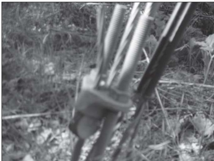
Рисунок 189. Монтаж клинового концевой зажима на трос оттяжки.
