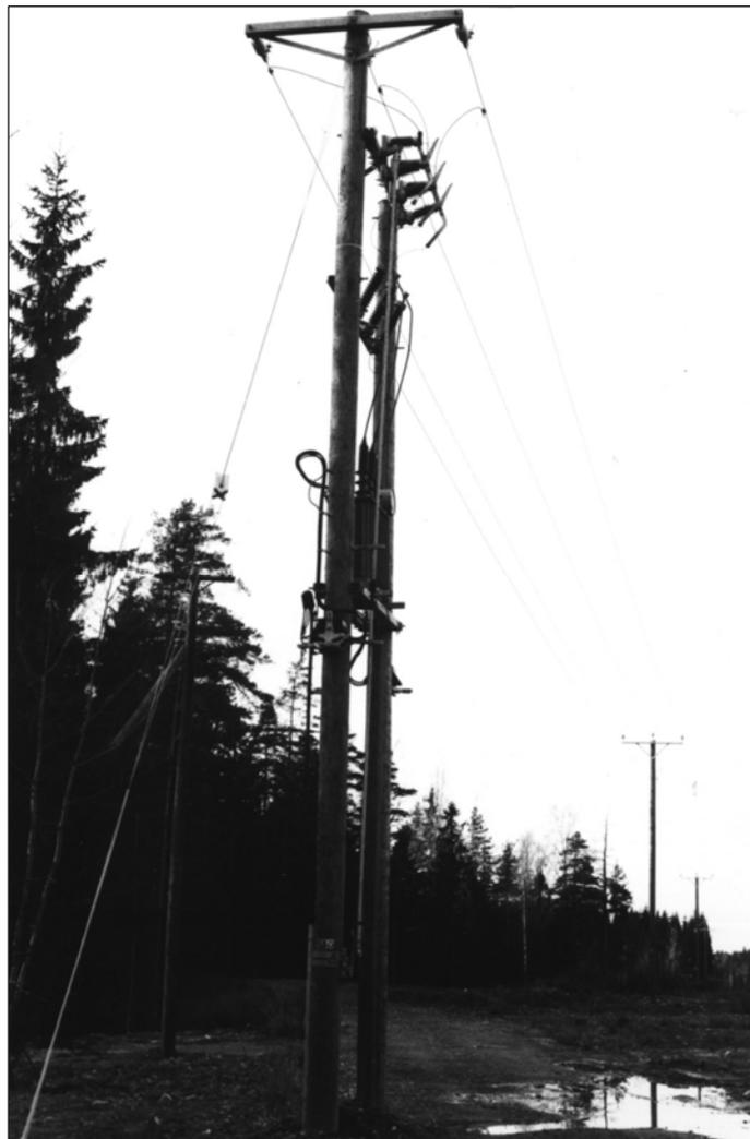
Рисунок 297. Линия электропередачи напряжением 20 кВ с неизолированными проводами на местности.
