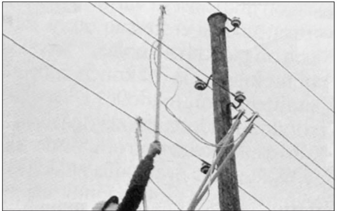
Рисунок 504. Производство рабочего заземления на линии низкого напряжения.
