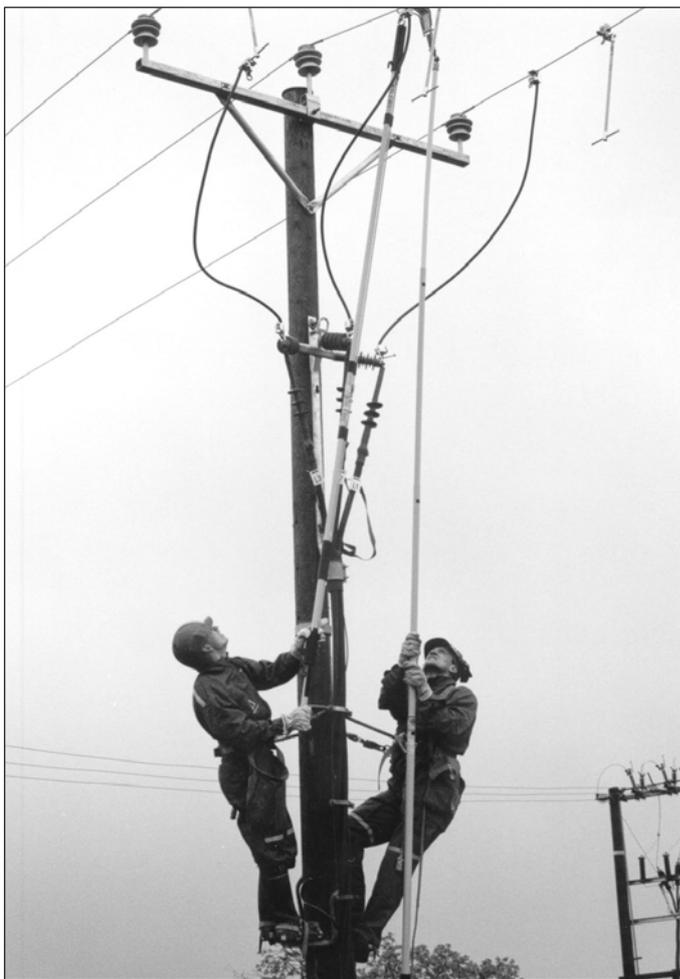
Рисунок 381. Подключение неокоренного подземного кабеля к магистральной линии 20 кВ под напряжением.
