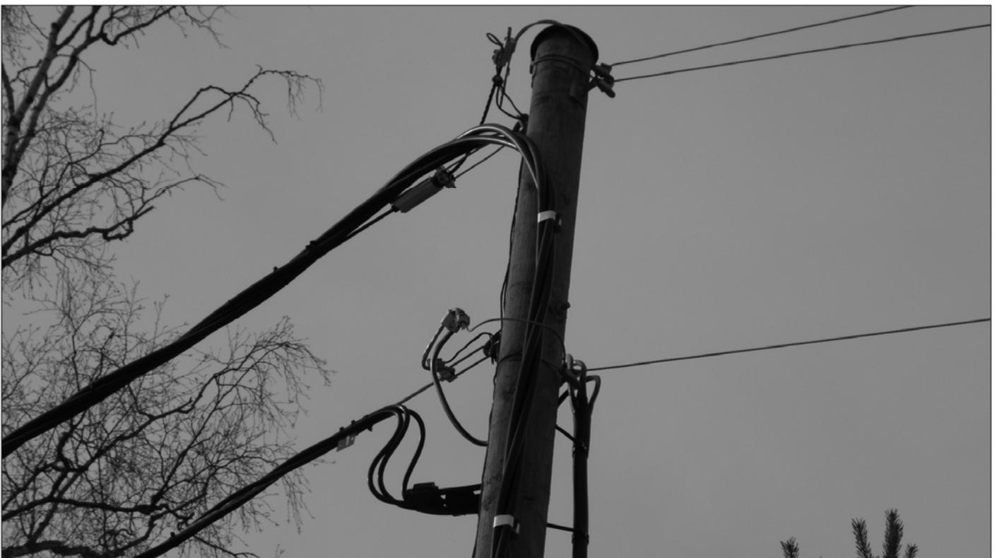
Рисунок 426. Переход кабеля АНХАМК-WM опорной установки в подземный кабель (Etelä-Suomen Energia).
