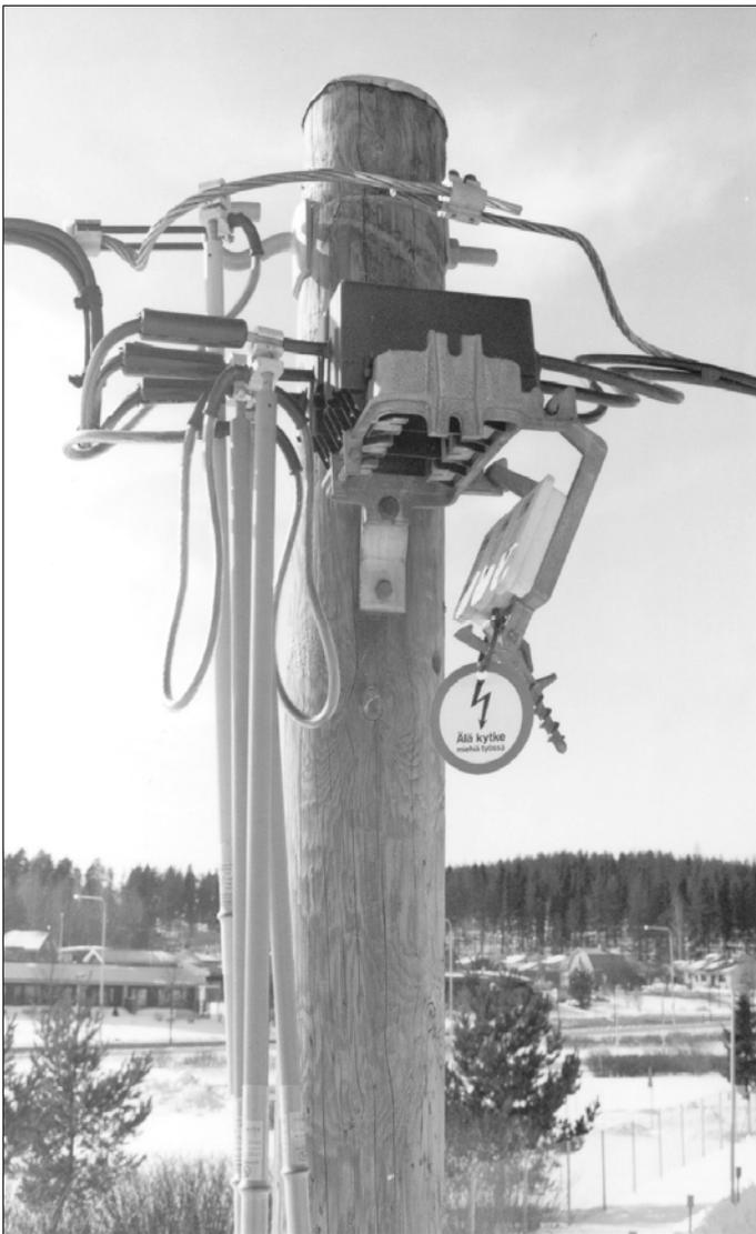
Рисунок 286. Запрещающий плакат, установленный на выключатель с плавким предохранителем.
