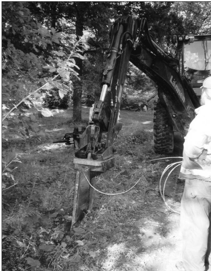
Рисунок 40. Плуг укладки электрода заземления, закрепленный к экскаватору.
