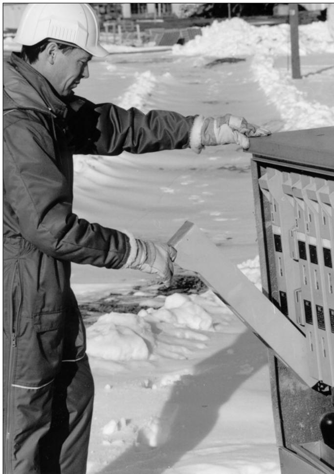
Рисунок 282. Отключение рабочего напряжения в кабельном распределительном шкафу осуществляется посредством удаления плавких вставок заданного направления линии.
