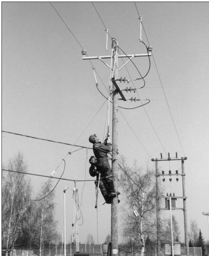
Рисунок 380. Подключение линии ответвления к магистральной линии напряжением 20 кВ под напряжением.
