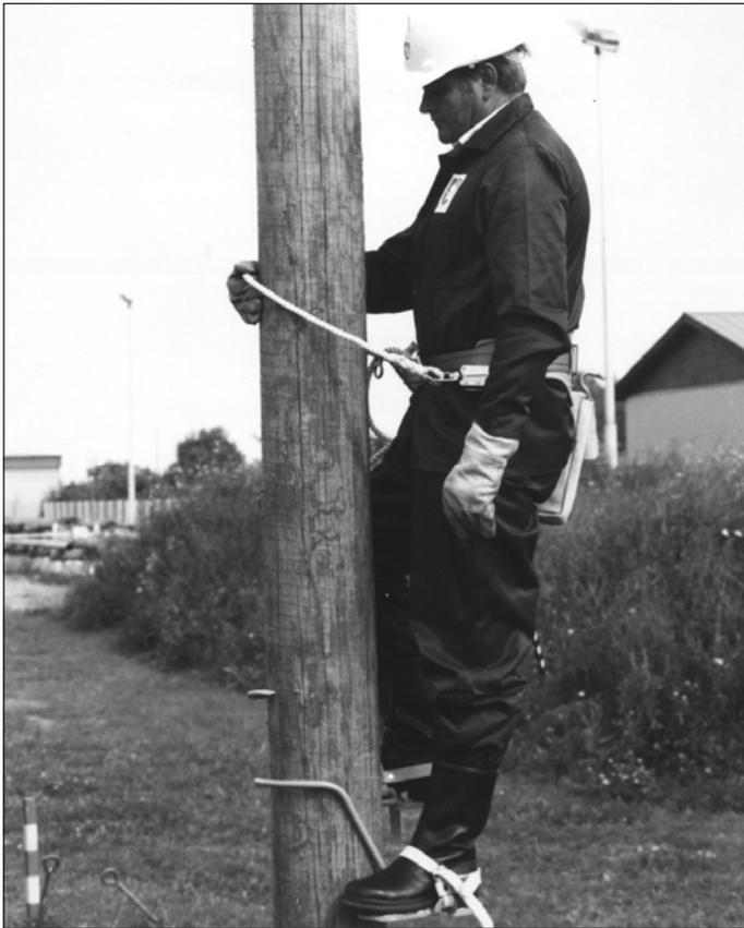
Рисунок 151. Во время подъема одной рукой следует придерживать за строп предохранительного пояса.
