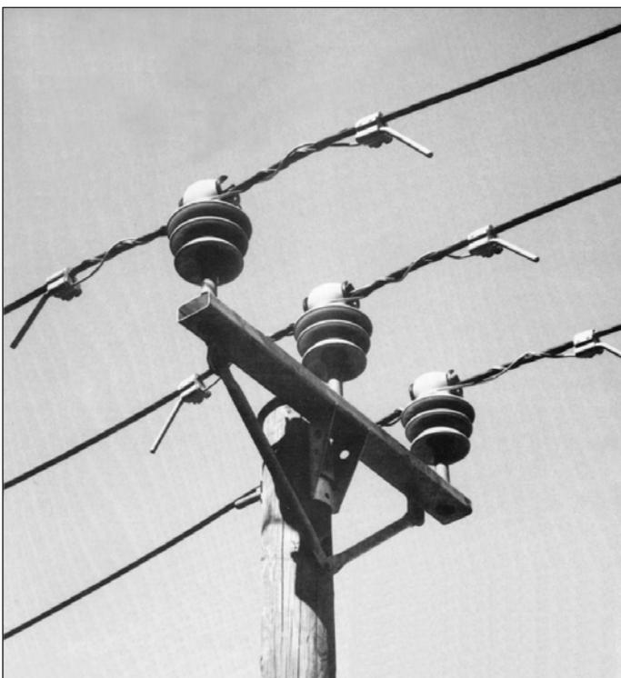
Рисунок 399. Обвязка провода PAS с помощью спиральной пружинной вязки.
