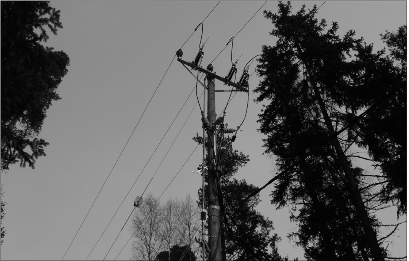
Рисунок 425. Переход неизолированного провода в кабель АНХАМК-WM опорной установки (Etelä-Suomen Energia).
