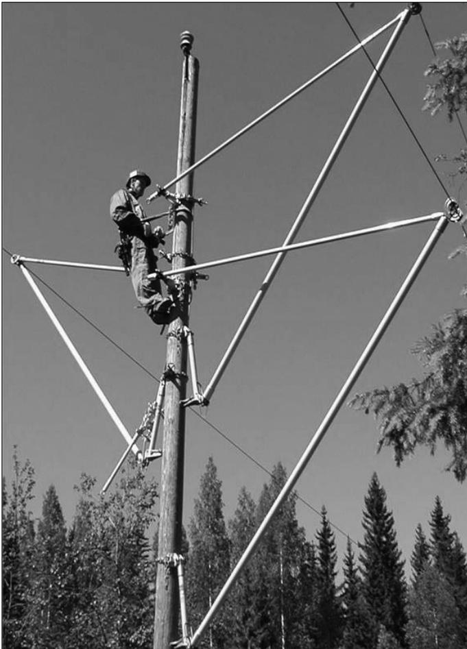
Рисунок 468. Работа по замене опоры под напряжением с применением изолированных штанг (JT-MILLENNIUM).
