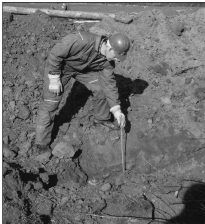
Рисунок 161. Контроль глубины котлована при установке опоры.
