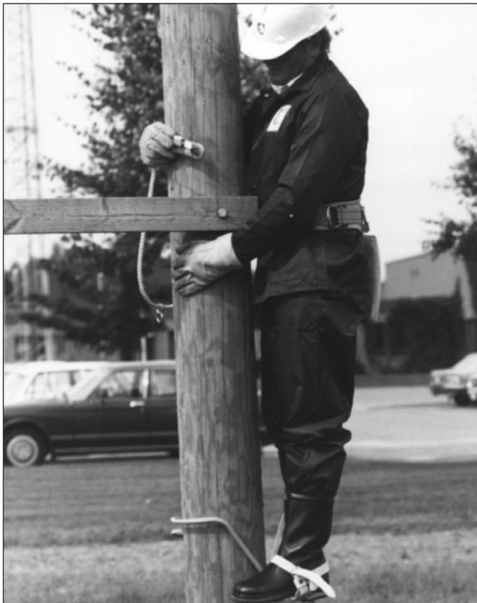
Рисунок 152. Если во время подъема строп приходится переносить через препятствие, то вначале через препятствие переносится один строп и крепится к предохранительному поясу, и только после этого отсоединяется второй строп в нижней части препятствия. Во время переноса стропов монтажник должен прочно опираться на монтажные когти.
