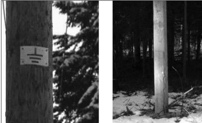
Рисунок 384. Обозначение места рабочего заземления (УЈ 8:09, рисунок 3).
