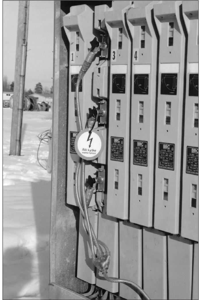
Рисунок 289. Рабочее заземление в кабельном распределительном шкафу.
