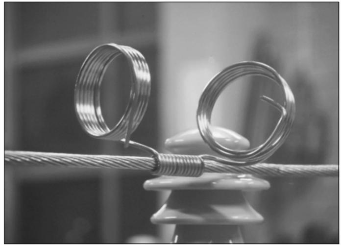
Рисунок 359. Производство защитной обмотки.
