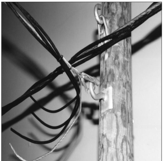
Рисунок 249. Оконцовка провода на опоре с помощью спиральной вязки.
