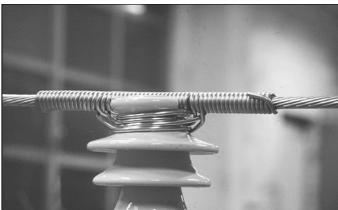
Рисунок 363. Крепление провода в верхний желоб с помощью вязки.
