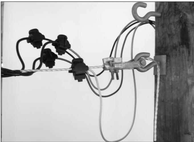
Рисунок 262. Образец соединения провода PEN с питающим кабелем.
