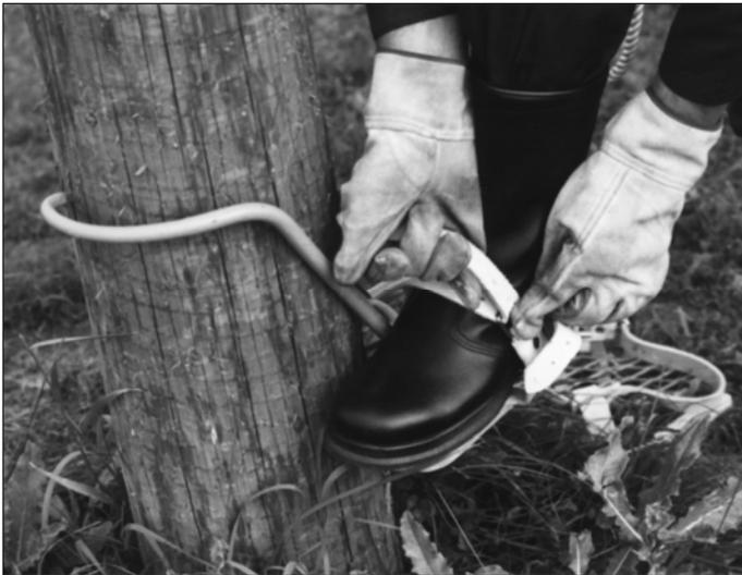
Рисунок 147. Монтерские когти надежно крепятся к прочной обуви. Предохранительный пояс крепится к поясу монтажника. При необходимости используются поддерживающие пояс наплечные лямки или жилет.
