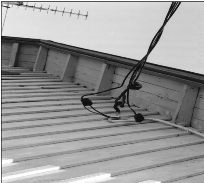
Рисунок 250. Оконцовка провода на стене с помощью спиральной вязки.
