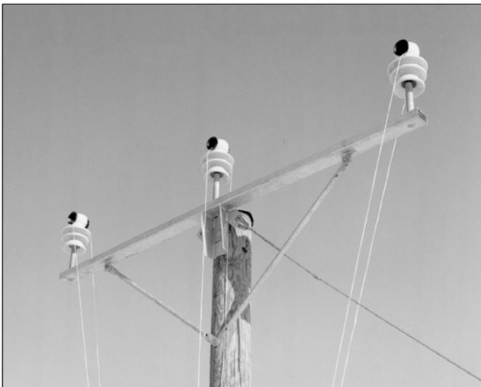
Рисунок 393. Тяговые веревки на опорном изоляторе.
