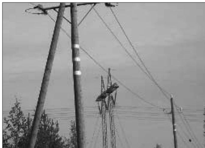
Рисунок 383. Предупредительная маркировка для пилотов вертолетов на опоре воздушной линии электропередачи напряжением 20 кВ (УЈ 8:09, рисунок на странице 6).
