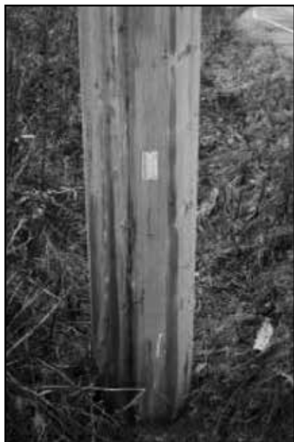
Joonis 80. Comwood liimpuitmast (Teevalgustuse/elektriala teatis nr 13, 1511. 2001 lk 3)
