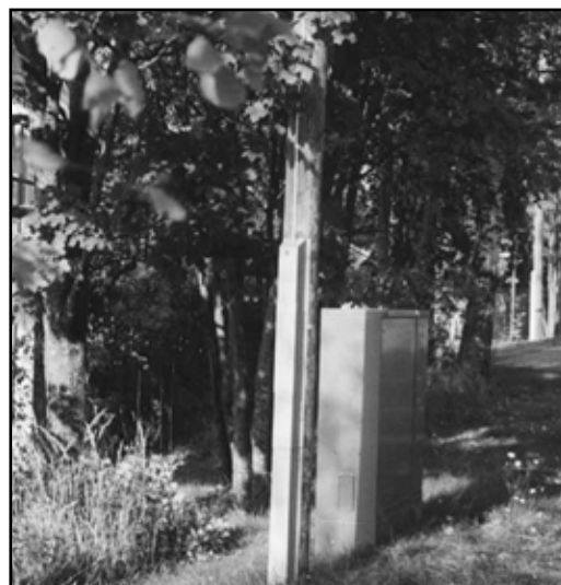
Joonis 58. Puitmastvalgustuse toitmine maakaablivõrgust.
