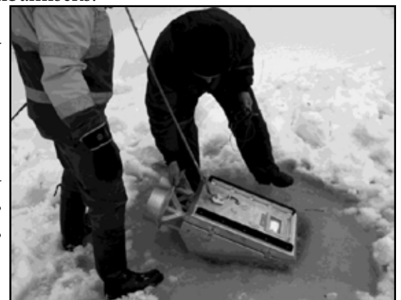
Joonis 213. Kaabli ujutamine jää alla ujuvrobotiga (Suur-Savon Sähkötyö).
