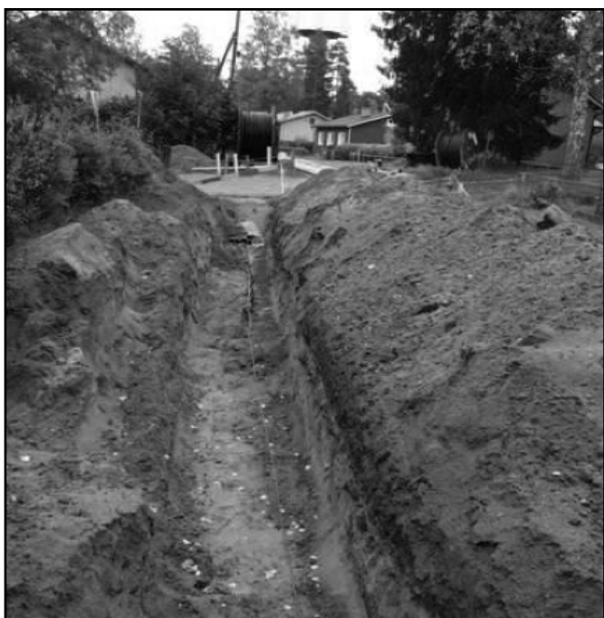
Joonis 67. Kaablikraav peaks olema võimalikult sirge (Pori Energia Sähköverkot).
