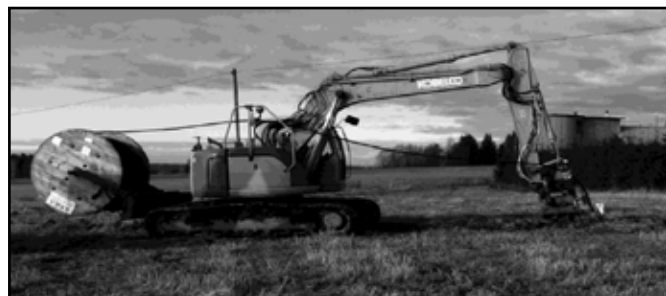
Joonis 117. Kaabliküündmine pinnasesse kaablitrumlit kandva masinaga (Suur-Savon Sähkötyö).
