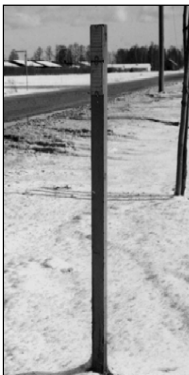
Joonis 43. Vee- ja kanalisatsioonitrasside maastikumärgid.
