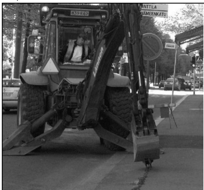
Joonis 68. Kaevemasin lõikab asfalti (Tampereen Vera).
