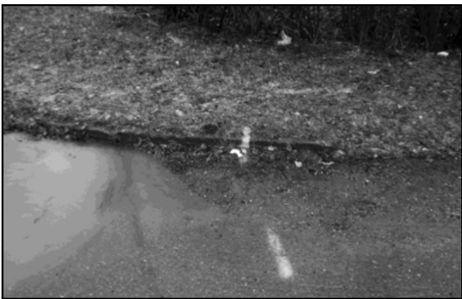
Joonis 71. Kaevetrassi tähistamine tee pealispinnal (Tampereen Vera).
