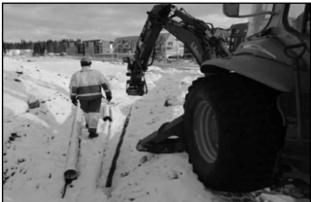
Joonis 93. Kaabli tõmbamine ekskavaatori vintsi abil (Tampereen Vera).
