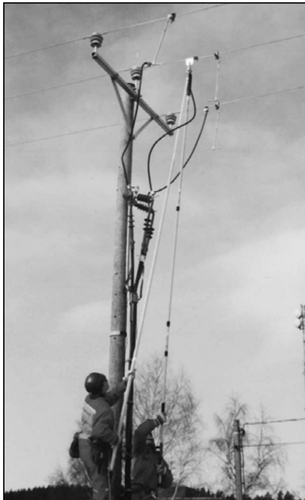
Joonis 181. Kaabli otsamuhvide ühendamine õhuliiniga pingevaluse tööna
