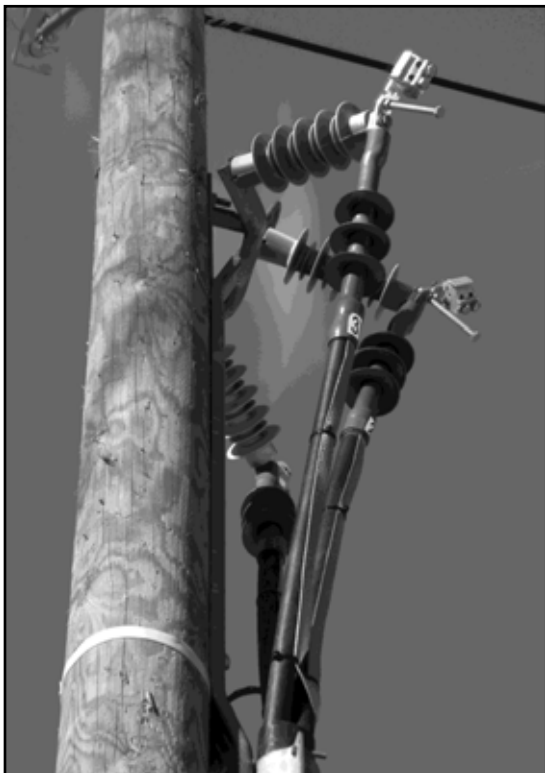
Joonis 178. Terminali raamile paigaldatud kaabli otsamuhv.
