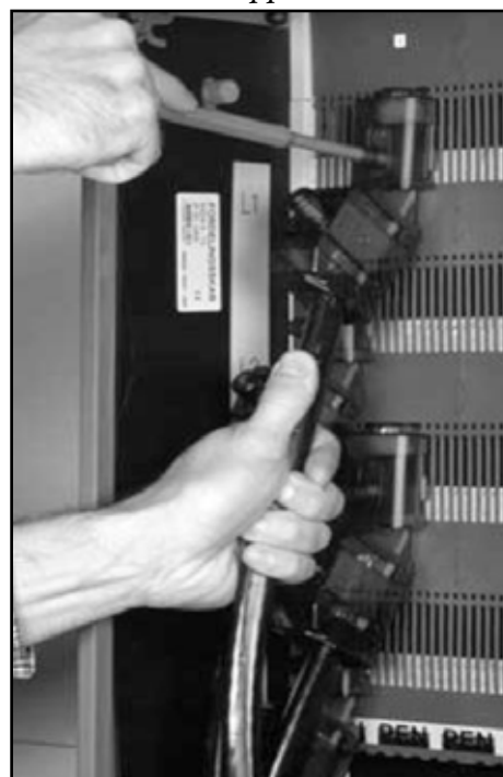
Joonis 196. Ühendamine latiklemmidega (nt KG 43) suoraan kokoojiin.
