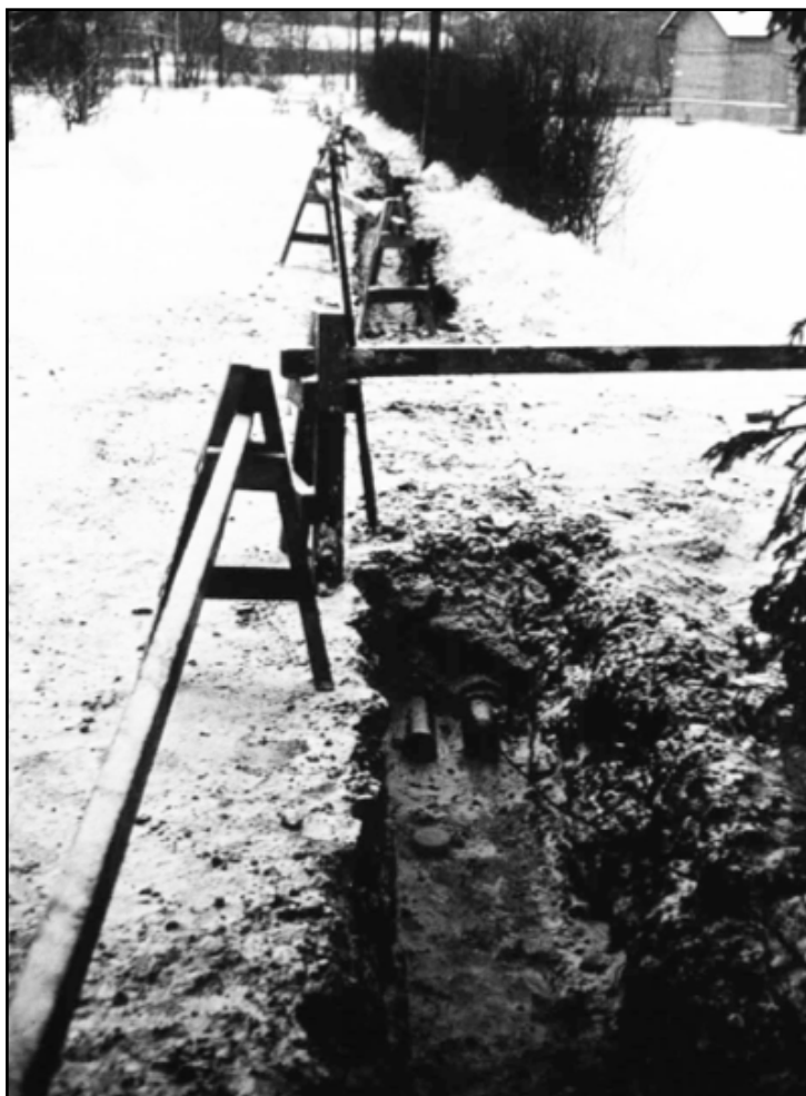
Joonis 73. Tüüpiline kaablikraav. Väljakaevatud pinnas on ära veetud, kuna see jääb talvisel ajal kraavi serval.
