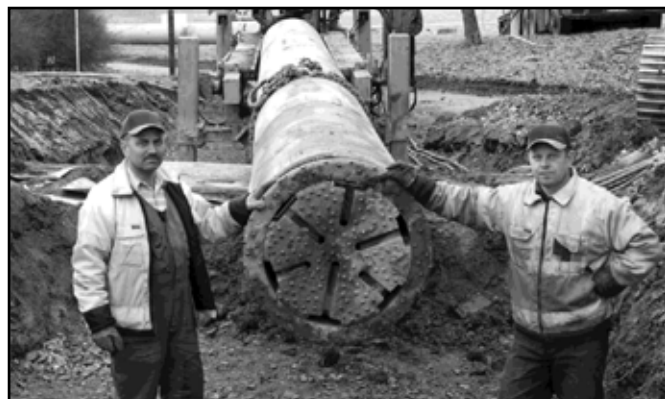
Joonis 81. Löökpuurimine, löögipea on kinnitatud kaitsetoru külge (Lännen Alituspalvelu).
