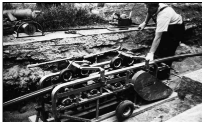
Joonis 107. Kaablitrassi keskele paigaldatud kaablitõmbamise seade.
