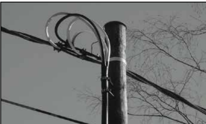
Joonis 119. Madalpingekaabli lõppühenduse näide.
