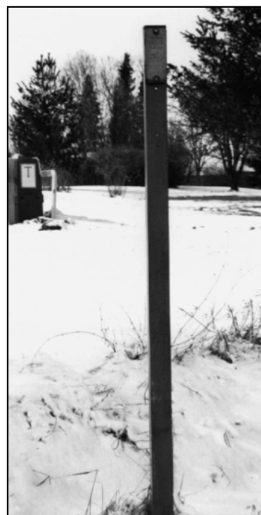
Joonis 44. Kaugküttetrasside maastikumärgid.
