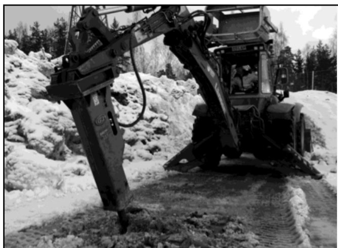
Joonis 69. Keltsakihi lõhkumine mehaanilise löökvasaraga (Tampereen Vera).
