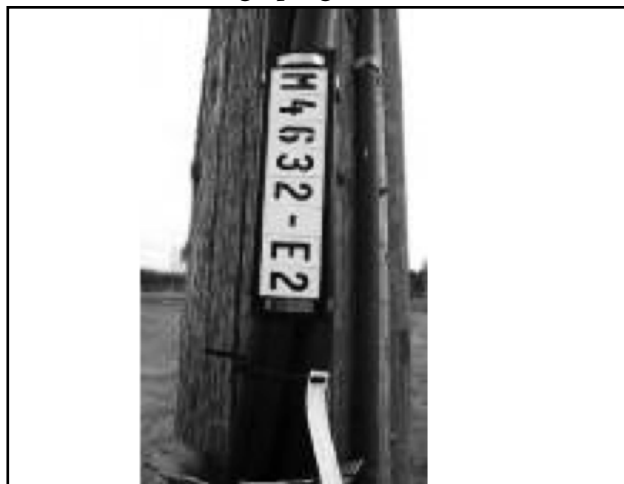
Joonis 182. 20 kV kaabli ülesviigu tähistamine (YJ 8:09).
