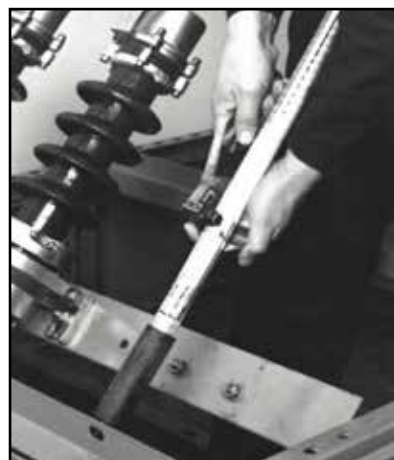
Joonis 241. Mantlilõikenoa kasutamine.
