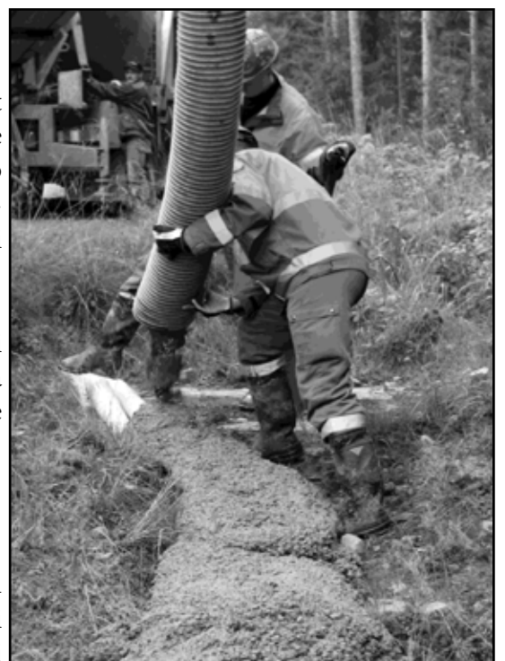
Joonis 217. Kaabli kaitsmine betoneerimisega (Suur-Savon Sähkötyö).
