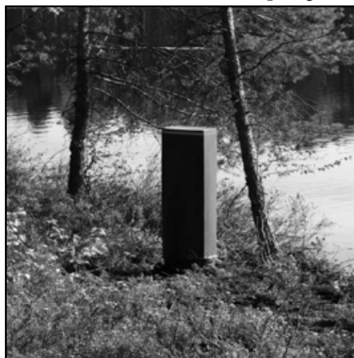
Joonis 205. Paigaldatud hargnemistoru HPPL 400 (Suur-Savon Sähkötyö).
