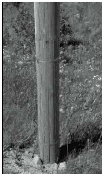
Joonis 82. Saetud sektoritest mast (Teevalgustuse/elektriala teatis nr 13, 1511. 2001 lk 8)
