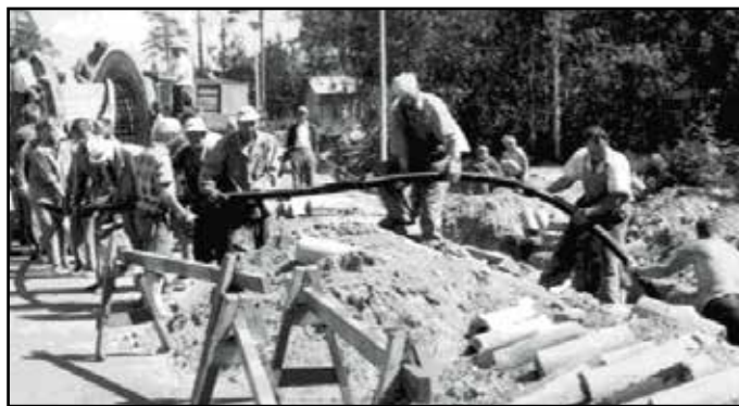
Joonis 228. Kaabli kandmine kaablikraavi inimjõul.
