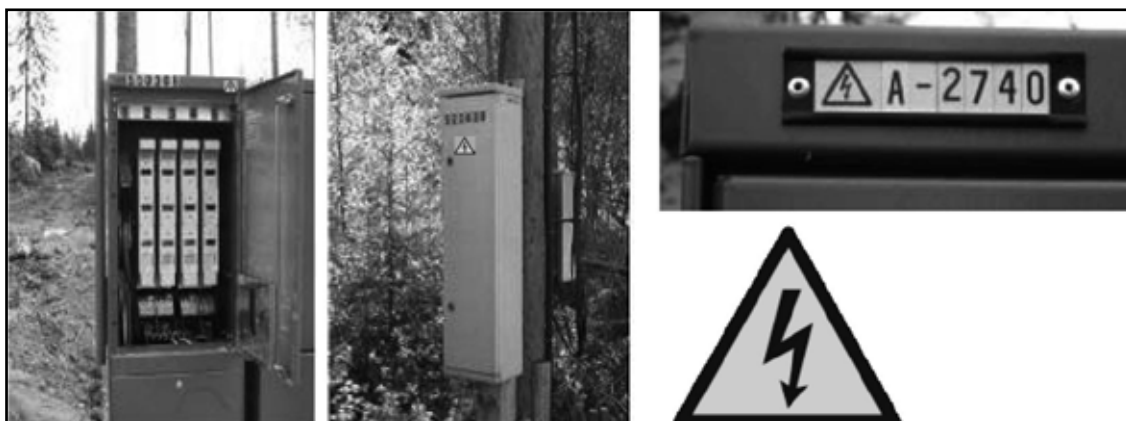
Joonis 206. Jaotuskapi tunnustähised ja elektriõhtu tähistav hoiatusmärk (YJ 8:09, joonis 11.)
