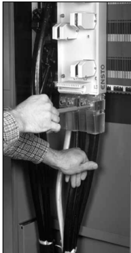
Joonis 194. Kaabli paigaldamine kappi.
