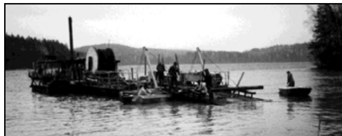
Joonis 211. Kaabli vettelaskmine parvlaevalt.
