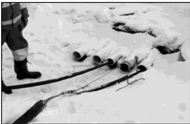
Joonis 95. Kaabli vedamine kaablitorustikku (Tampereen Vera).
