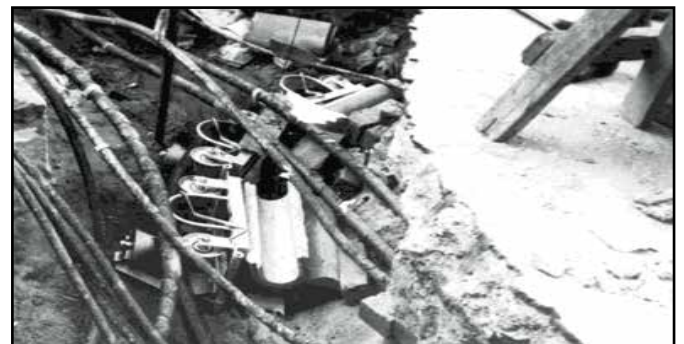
Joonis 75. Kaevisest esile tulevate kaablite toetamine.
