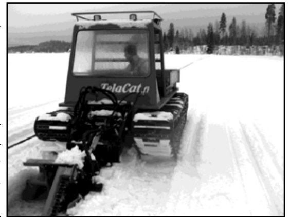
Joonis 214. Kaabli vettelaskmine jäässe küntud prao kaudu (Suur-Savon Sähkötyö).
