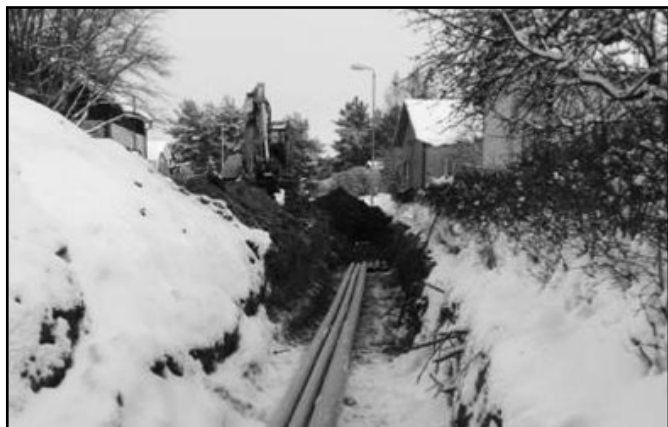
Joonis 72. Ekskavaator kraavi kaevamas (Pori Energia Sähköverkot).
