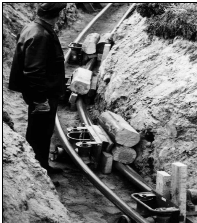
Joonis 103. Lauge käänak (Tähelepanu, paigaldaja tööriivad ei vasta nüüdisaegsetele nõuetele).
