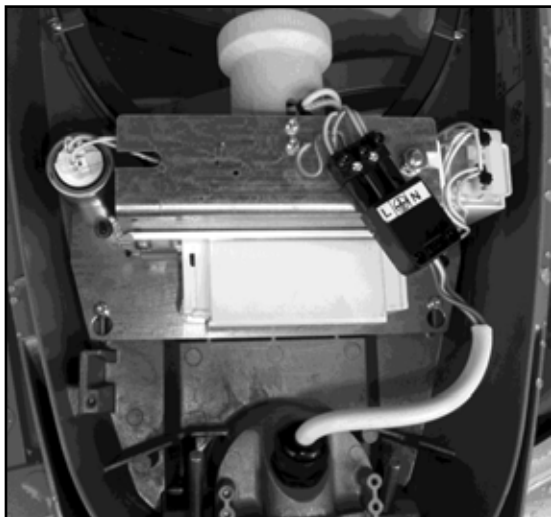
Joonis 15 Liiteseadmete paigaldamine mastivalgusti korpusesse.
