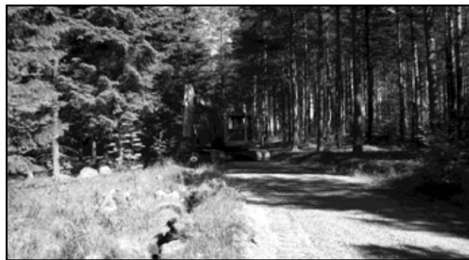
Joonis 118. Kaabli sissekündmine tee serval (Suur-Savon Sähkötyö).
