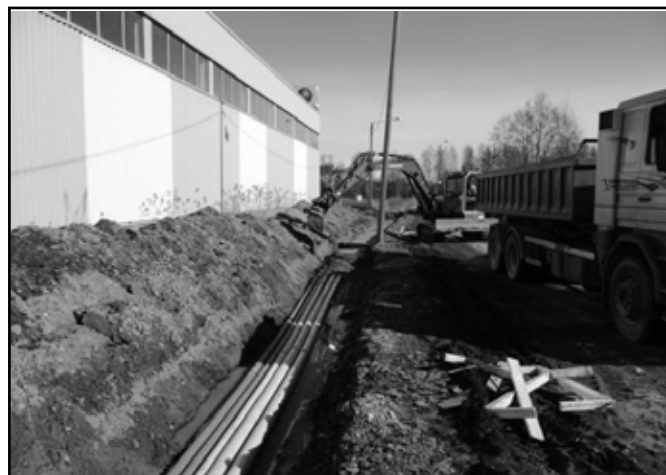
Joonis 158. Kaablikaitsetorud kaablikraavis (Pori Energia Sähköverkot).
