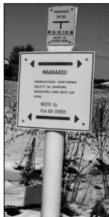
Joonis 45. Maagaasitorude maastikumärgid.
