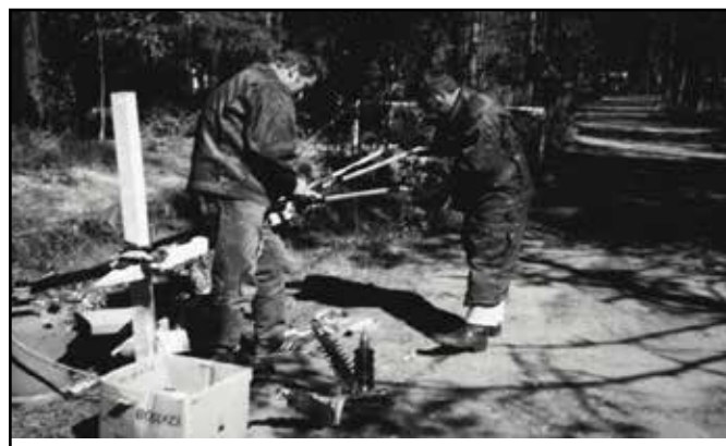
Joonis 176. Mastile paigaldatava kolme mantliga kaabli otsmuhvi tegemine maapinnal.
