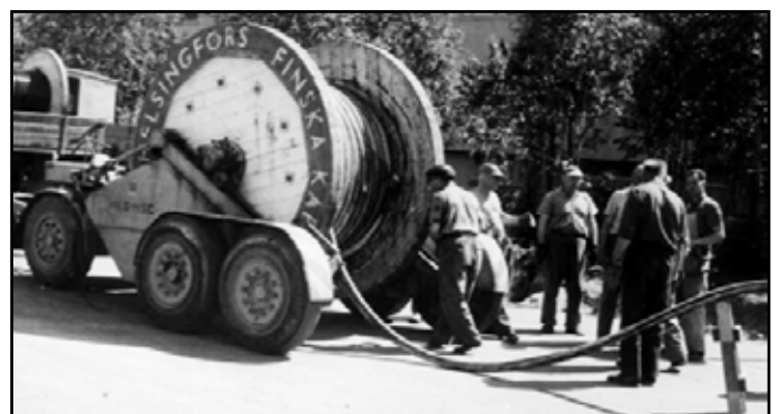
Joonis 227. Kaabli langetamine kraavi otse kaablitrumli veokilt.
