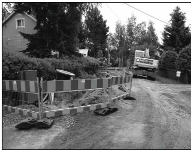
Joonis 59. Kaablikraavi kaitsmine kaitsepiirdega (Pori Energia Sähköverkot).
