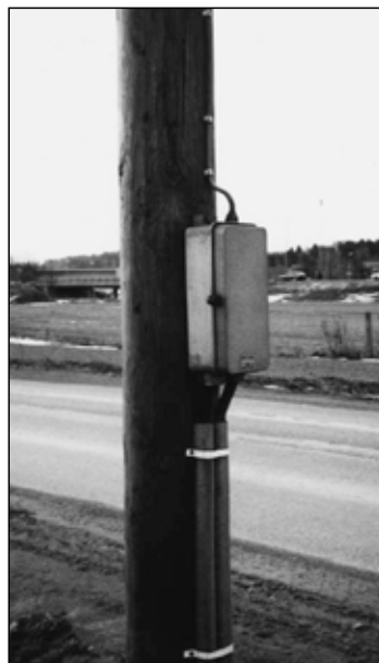
Joonis 16 Liiteseadmete paigaldamine eraldi ühenduskarpi.
