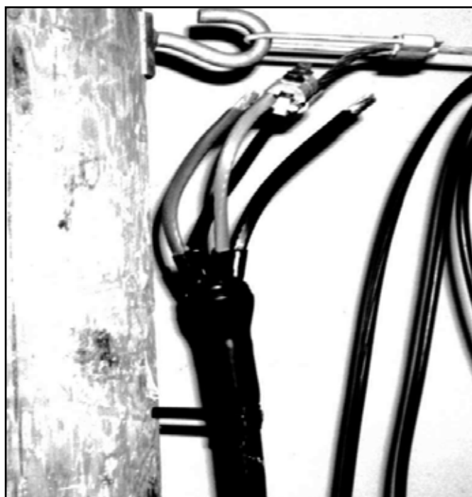
Joonis 122. Termokahanevast plastist muhv plastmaakaablile AXMK.
