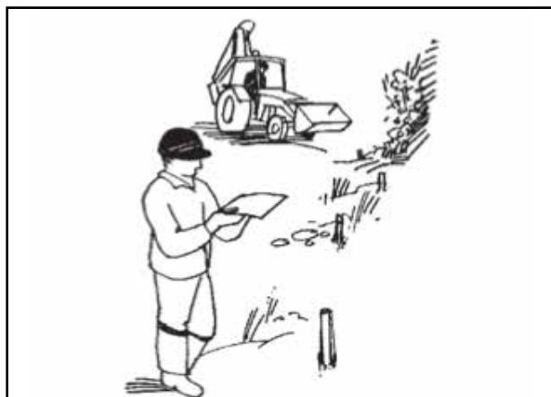
Joonis 50. Kaablitrassi tähistamine väljaarendamata piirkonnas
