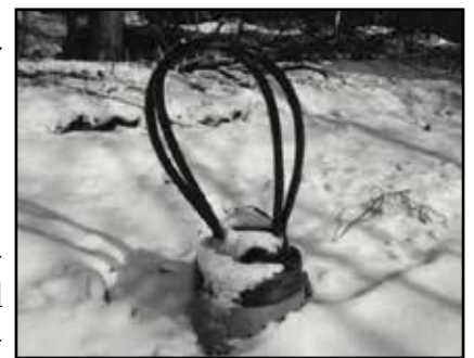
Joonis 69. Kaablile ühendamiseks jäetakse piisavalt vaba pikkust.
